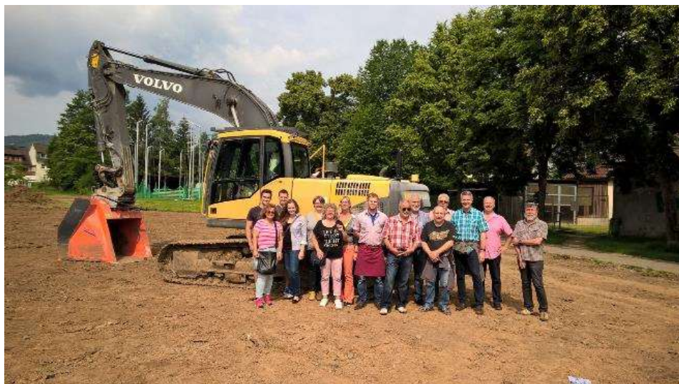
Baustelle Neuer Supermarkt
